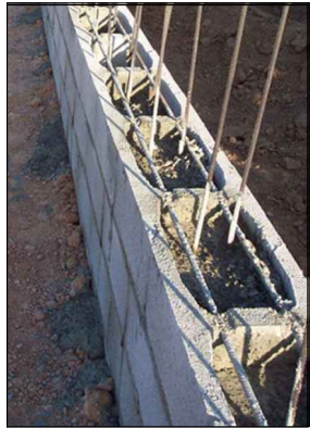
Detall mur de bloc H armat
