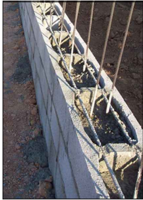
Detall mur de bloc H armat
