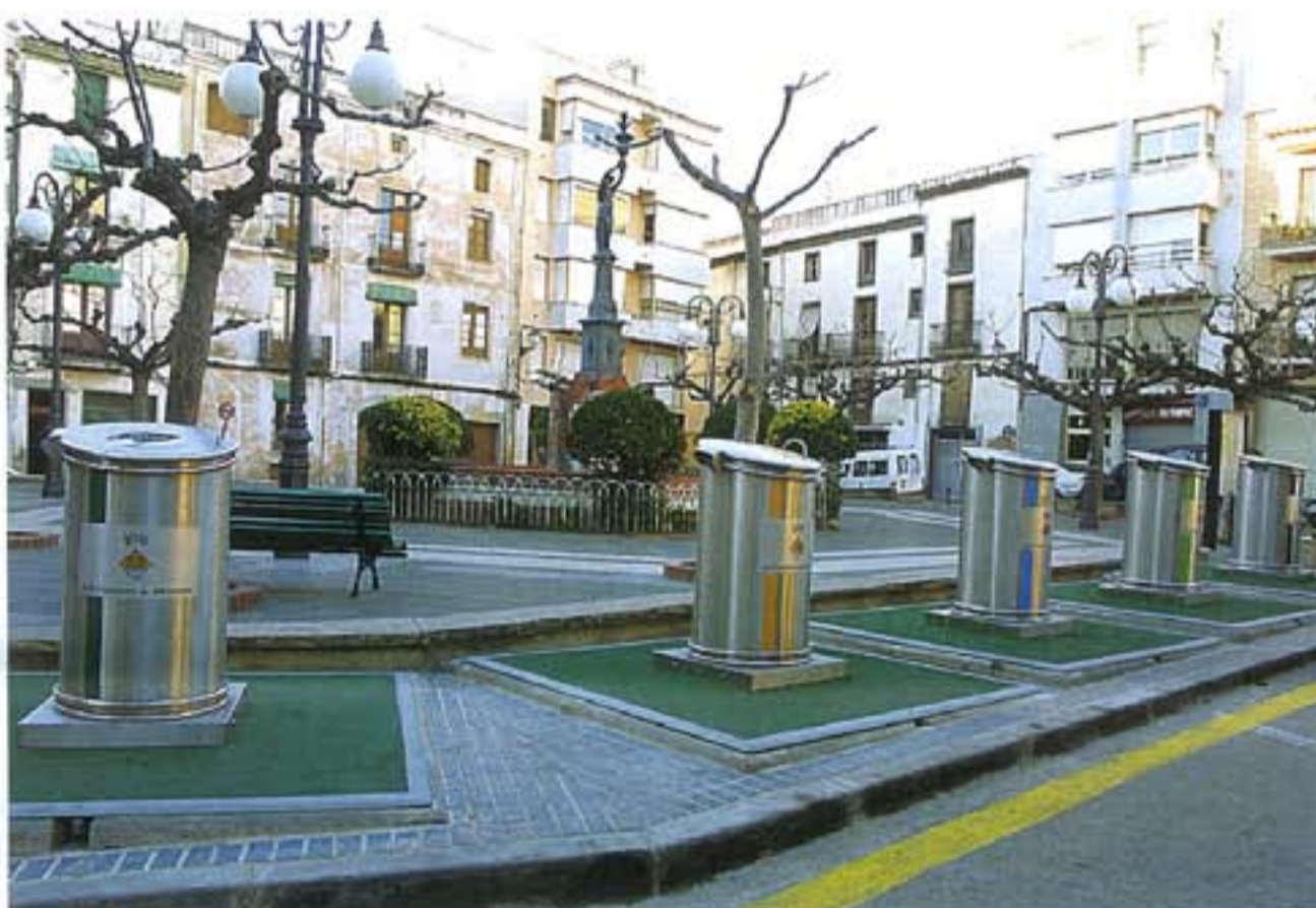
Una de les cinc bateries de contenidors soterrats instal·lades al casc urbà, concretament a la plaça Petita.
