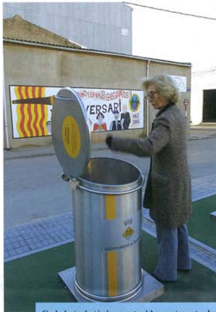
Cada bateria té cinc contenidors soterrats, de 3.000 litres de capacitat cada un.
