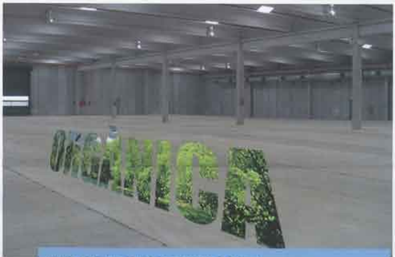
Interior de la nova nau de compostatge de Botarell
