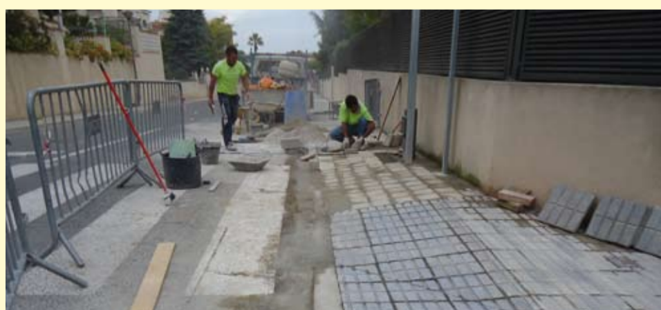
Contínuament, eliminació de les barreres arquitectòniques
