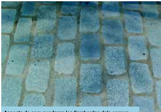
Aspecte de com quedaran les llambordes dels carrers.
