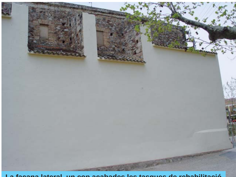
La façana lateral, un cop acabades les tasques de rehabilitació
