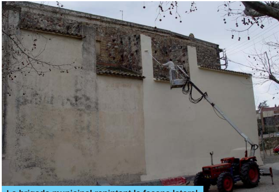
La brigada municipal repintant la façana lateral
