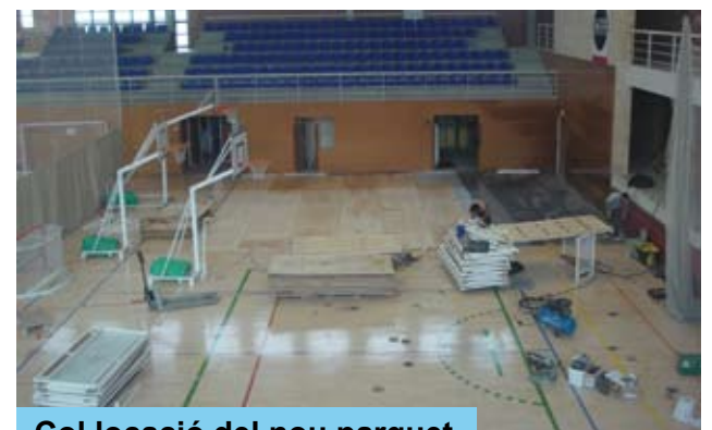
Col·locació del nou parquet
