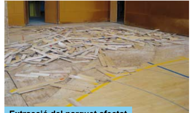
Extracció del parquet afectat
