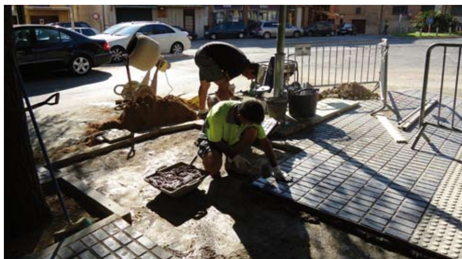
Reparant una vorera de l'Avinguda de Josep M. Sentís
