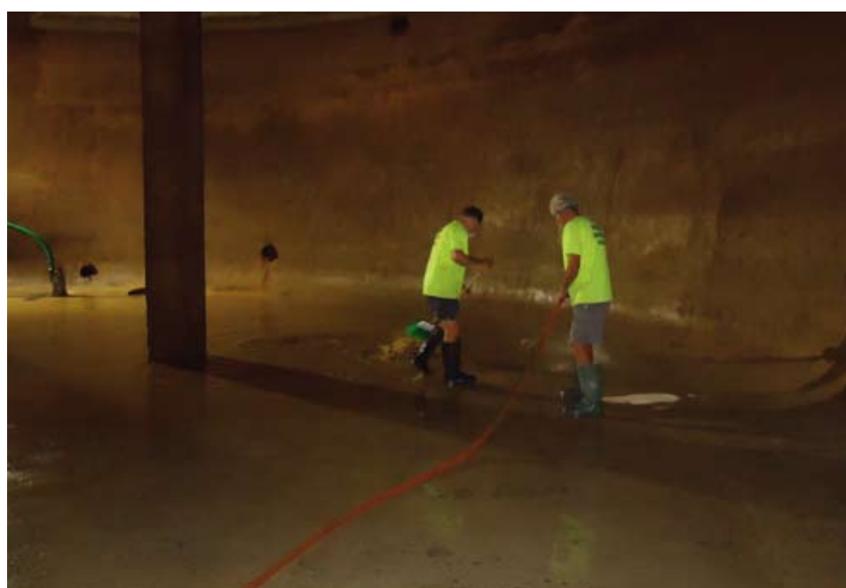
Interior d'un dels dipòsits
