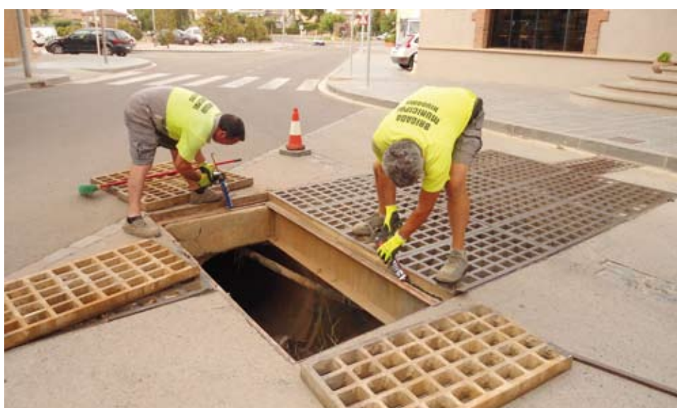
Manteniment de les reixes per evitar el soroll excessiu
