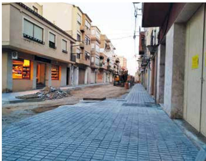
La remodelació del carrer de Sant Pau, un dels carrers amb major intensitat de circulació diària, comportarà una reordenació de la circulació a l'eixample nord del municipi.
