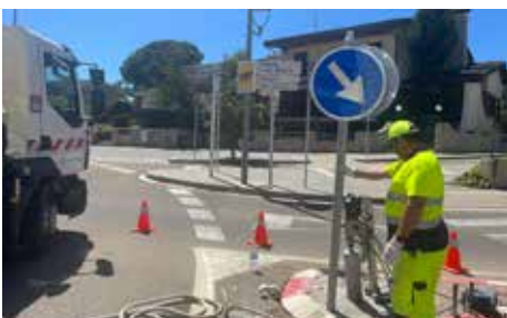
Entrada de la carretera de Vinyols
