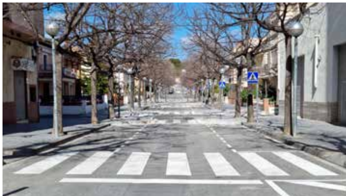
Estat de l'avinguda Primer d'Octubre una vegada acabades les obres.
