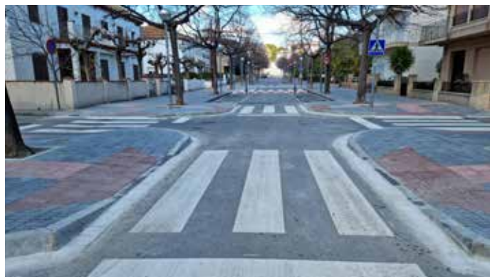
Ampliar les voreres a les cruïlles fa que els vehicles redueixin la velocitat al seu pas.
