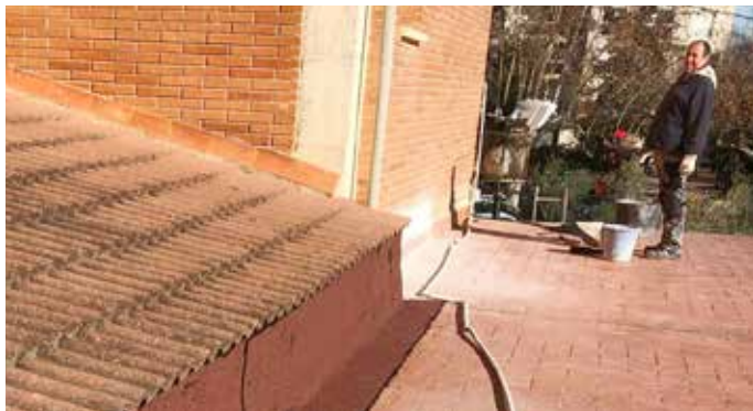
Escola Beat Bonaventura: impermeabilització i arranjament d'una claraboia i d'una paret lateral.
