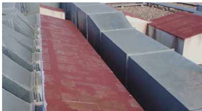
Biblioteca: impermeabilització de dues casetes del terrat.
