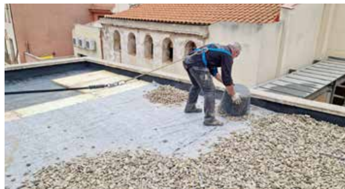
Escola de Música: impermeabilització i arranjament de dues parts de la coberta.
