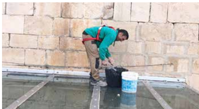
Casal i Llar de jubilats: impermeabilització i segellat de diversos punts per evitar filtracions.
