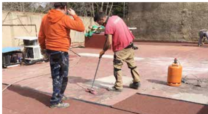
Restaurant de Sant Antoni: impermeabilització i arranjament del terrat.
