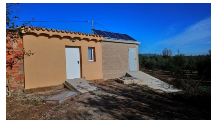
9. Vista parcial de l'edificació de recent construcció pertanyent a caseta de serveis de la Comunitat de Regants del Pantà de Riudecanyes, localitzada al límit nord-oest de la finca de propietat.
