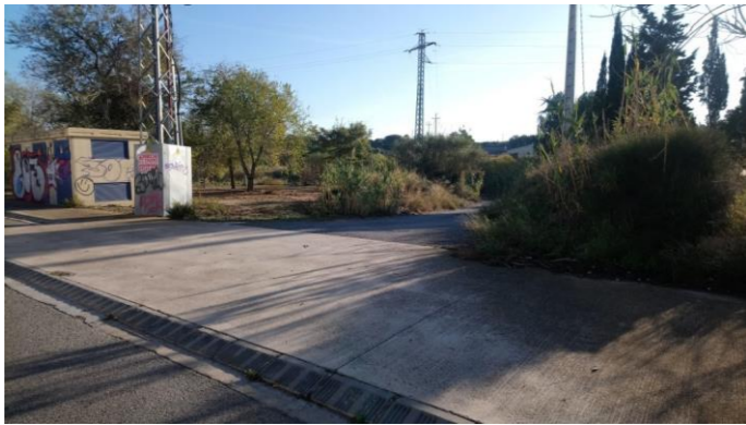
1. Accés a l'àmbit de la finca des del PI. El Prat, zona sud-est, pel camí del Mas del Figueres o del Mas Gasset, pavimentat i que travessa la riera de Riudoms.
