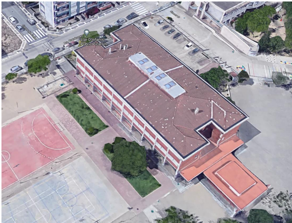
ESTAT ACTUAL DE LA COBERTA ON S'UBICARÀ LA INSTAL·LACIÓ.
