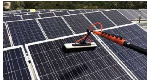
Sistema de neteja amb aigua pura i bastons telescòpics
