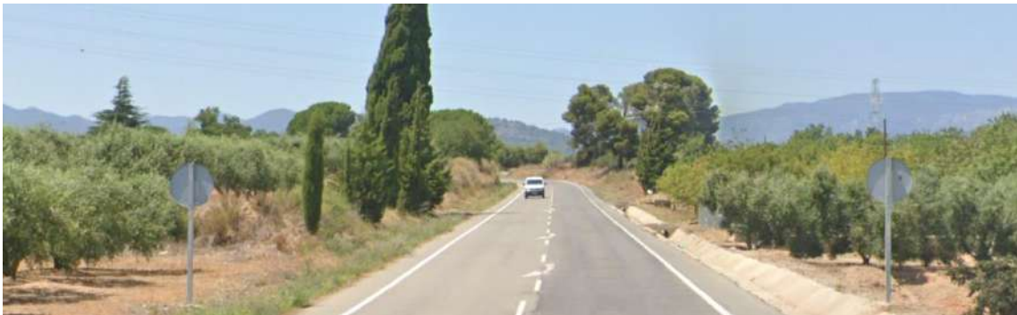
Figura 15: Vista de la carretera comarcal TV-3101 que connecta Riudoms amb les Borges del Camp.
