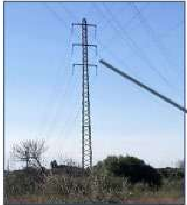
Torre metàl·lica existent
