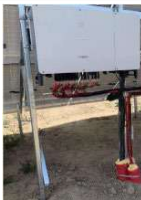
Canalització de les series de CC dels mòduls als inversors.
