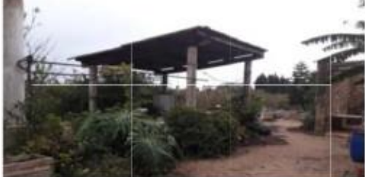
2 Cobert a enderrocar de mides aprox. 4,80x4,80m
