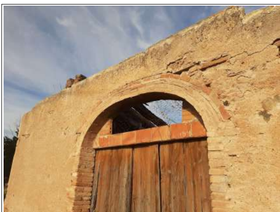
Imatge 2: Cromatisme de la façana actual
