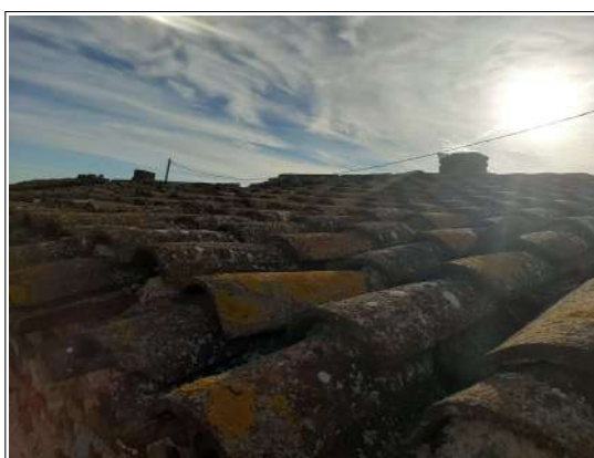
Imatge 3: Teules a recuperar per tapa de la coberta nova
