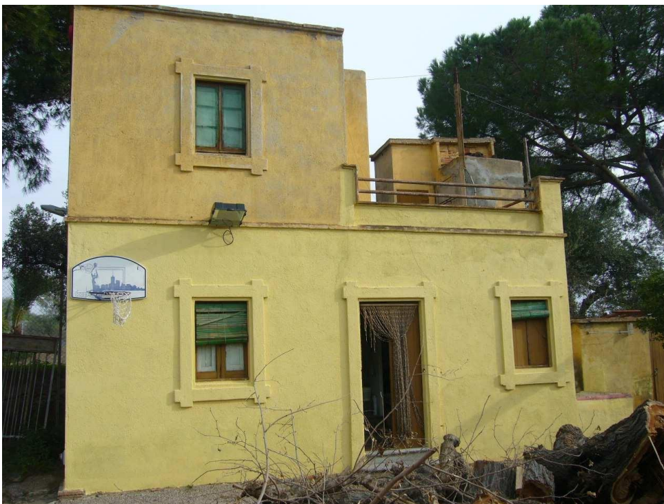
FAÇANA PRINCIPAL DE LA MASIA
