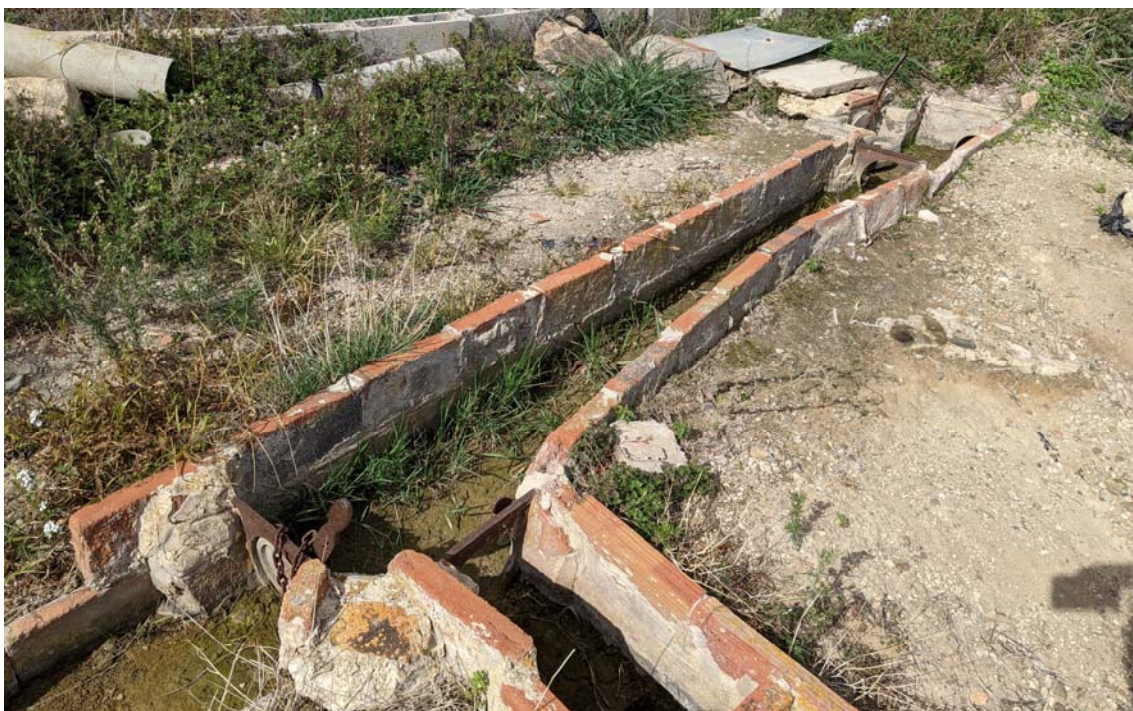
Imatge de la sèquia a l'entrada de la finca
