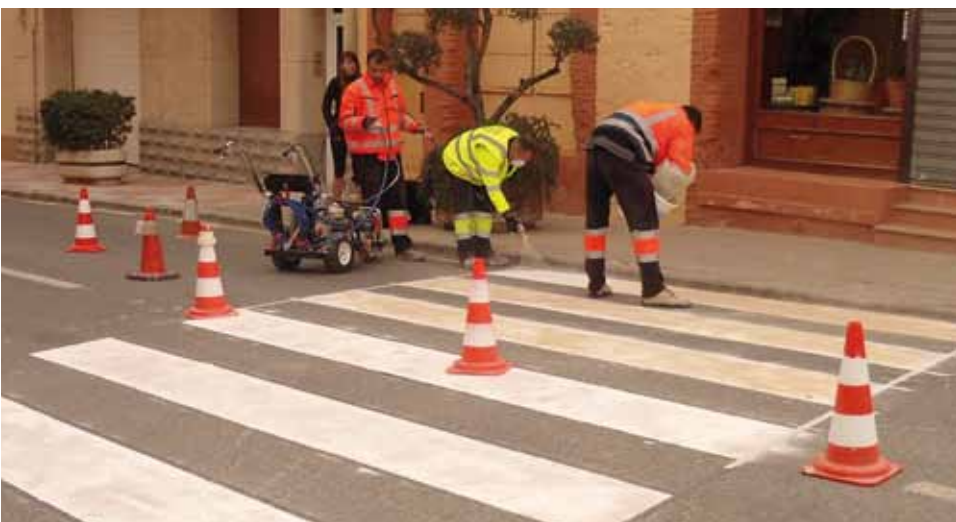
S'ha comprat una nova màquina per l'aplicació de pintura vial
