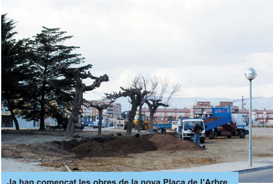
Ja han començat les obres de la nova Plaça de l'Arbre.
