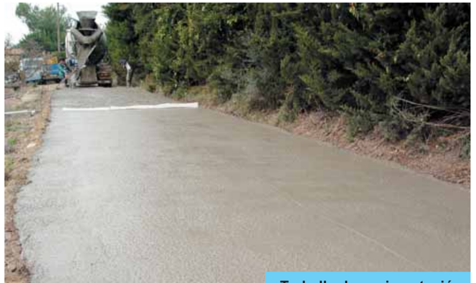
Treballs de pavimentació.
