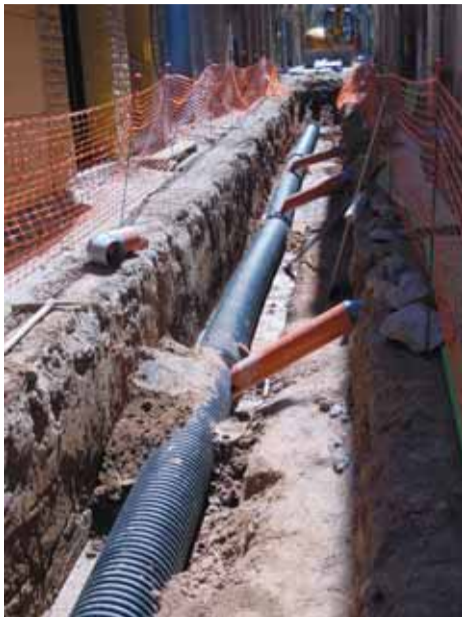
Les obres del carrer del Beat
