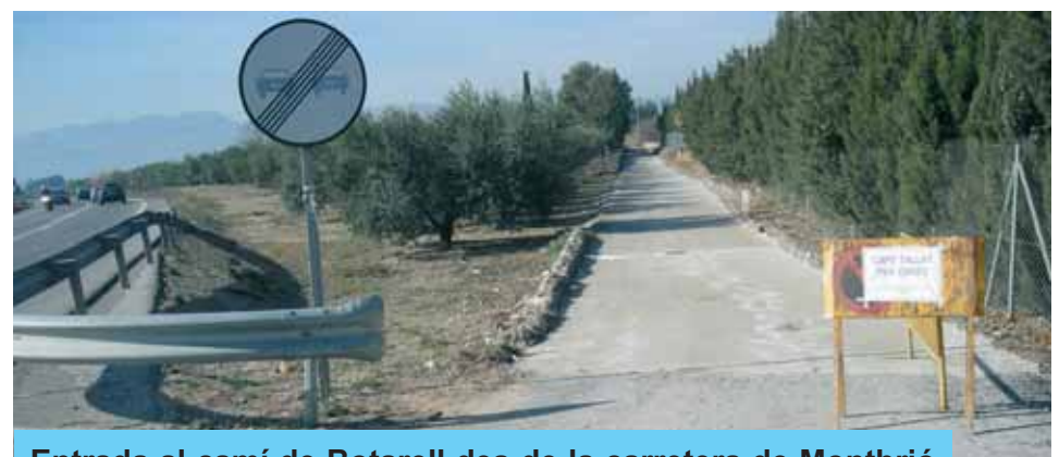
Entrada al camí de Botarell des de la carretera de Montbrió
