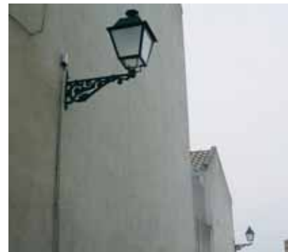
Els llums ja estan instal·lats
