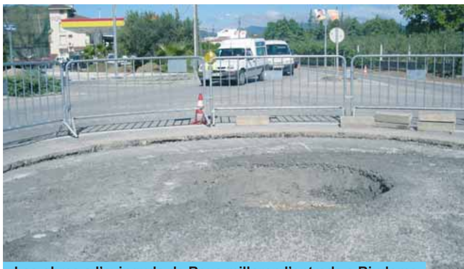
Les obres a l'avinguda de Reus milloren l'entrada a Riudoms
