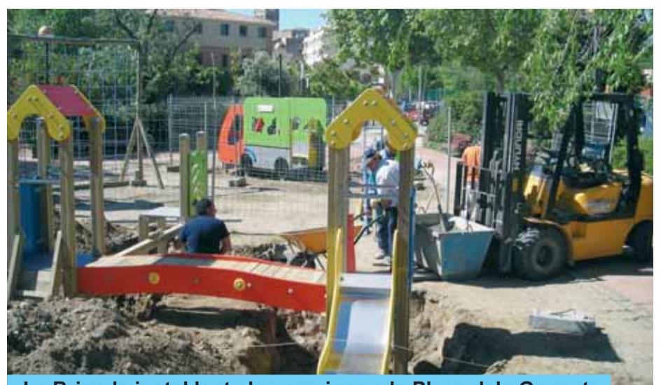
La Brigada instal·lant els nous jocs a la Plaça dels Gegants
