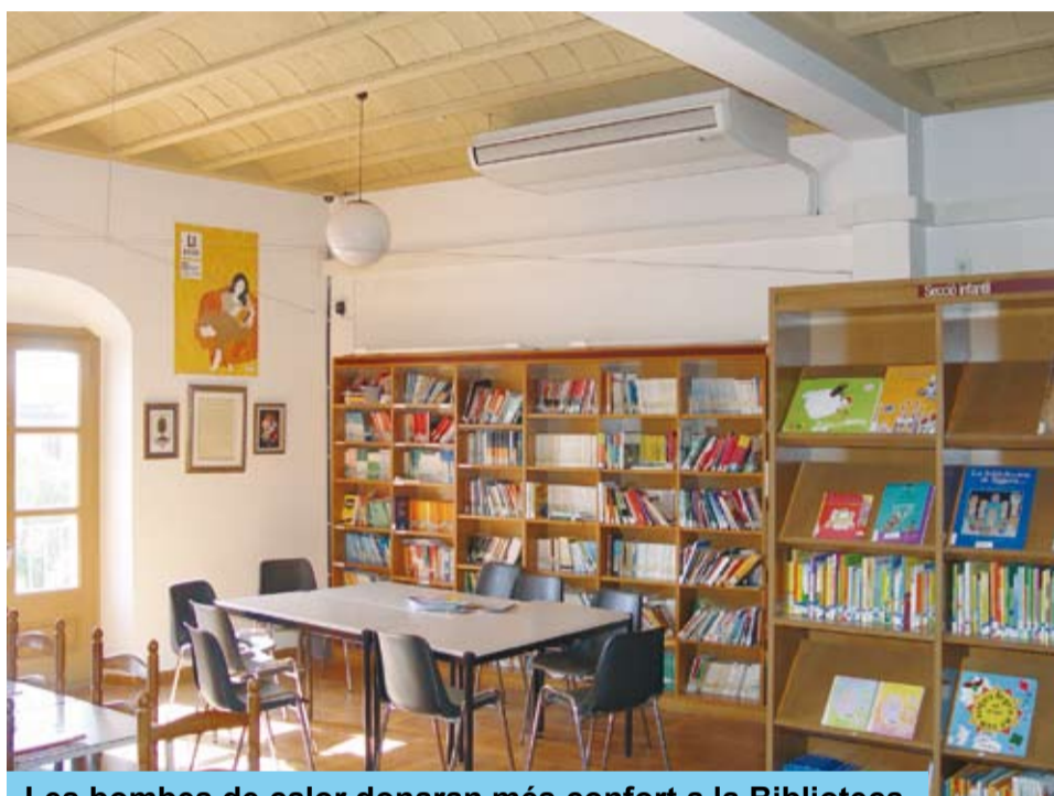
Les bombes de calor donaran més confort a la Biblioteca
