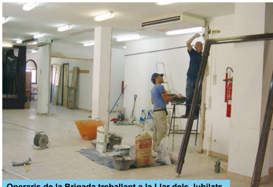
Operaris de la Brigada treballant a la Llar dels Jubilats
