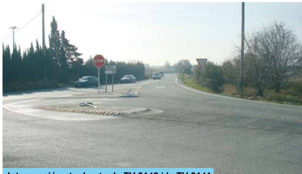
Intersecció actual entre la TV-3142 i la TV-3141
