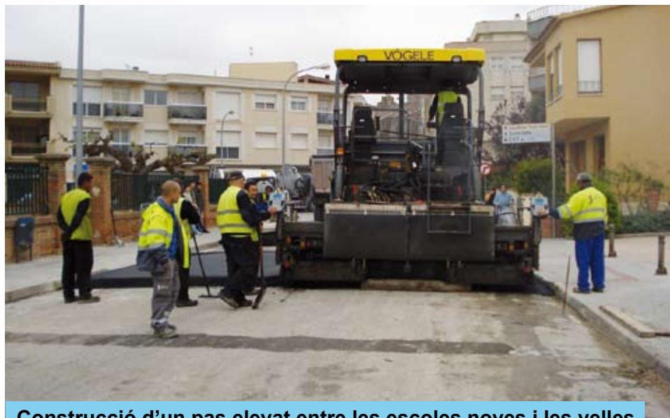
Construcció d'un pas elevat entre les escoles noves i les velles
