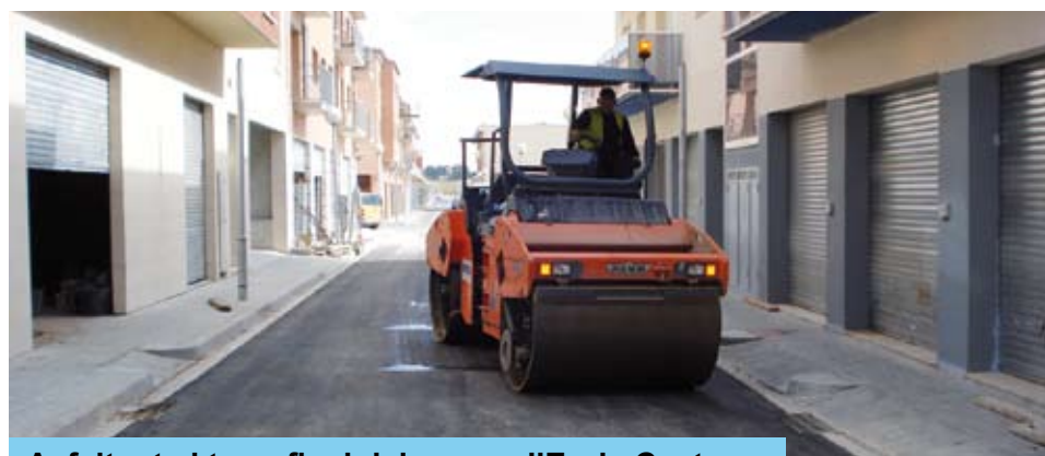
Asfaltant el tram final del carrer d'Enric Castro
