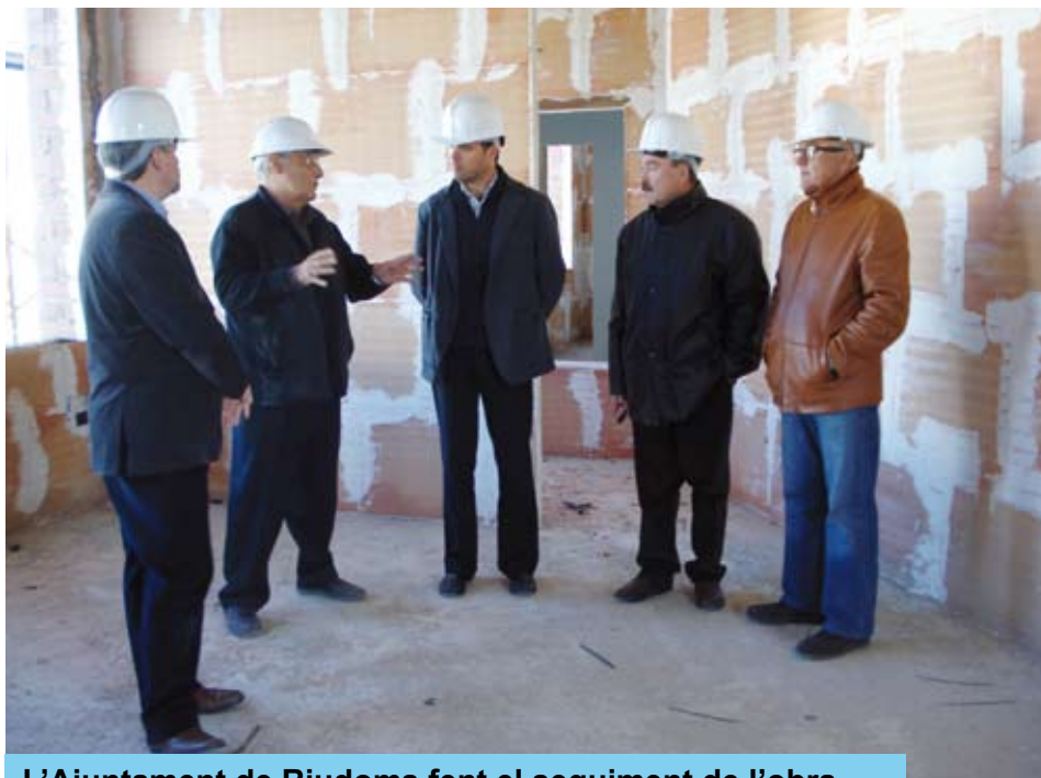
L'Ajuntament de Riudoms fent el seguiment de l'obra
