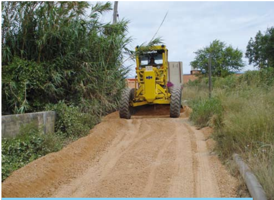
Condicionament del terreny abans de l'aplicació del formigó
