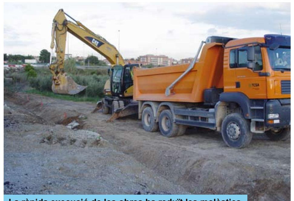
La ràpida execució de les obres ha reduït les molèsties
