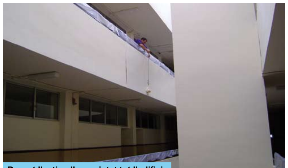
Durant l'estiu s'ha repintat tot l'edifici
