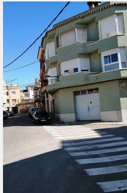
Figura 44. Avinguda Verge de Montserrat (itinerari escolar no accessible)
