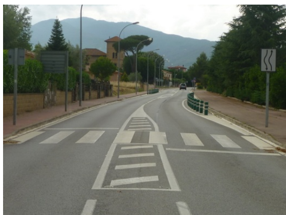
Imatge 82. Exemple de mitjana pintada, estrenyent els carrils de circulació per moderar la velocitat. Aquí s'ha combinat amb trencament horitzontal de l'eix de la trajectòria.
