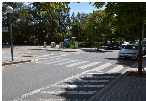
Imatge 11. Av. Josep Maria Sentís amb av. Catalunya. Manca de pas de vianants i manca de visibilitat abans de pas de vianants per estacionament de vehicle.
