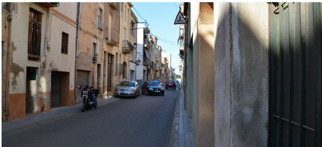
Imatge 45. Vista de l'av. Pau Casals, abans d'arribar a av. Verge de Montserrat. Voreres estretes, parada de vehicles generant situacions de risc a la calçada.
