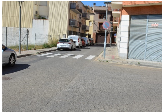
Imatge 3. Senyalització vertical en mal estat pel pas del temps. C. dels Molins Nous.
