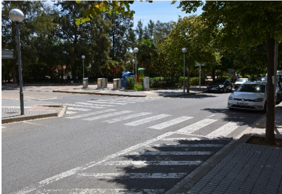
Imatge 6. Manca de pas de vianants per completar la intersecció. Av. Josep Maria Sentís.
