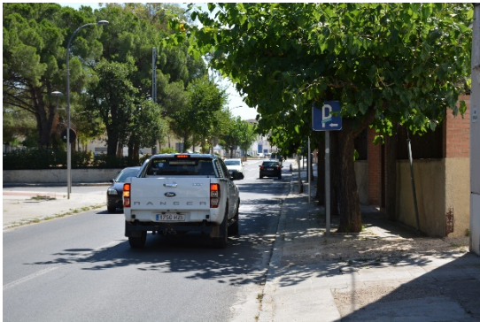
Imatge 4. Senyalització en mal estat per vandalisme i arbrat que pot dificultar la seva visibilitat. Av. de Reus.
