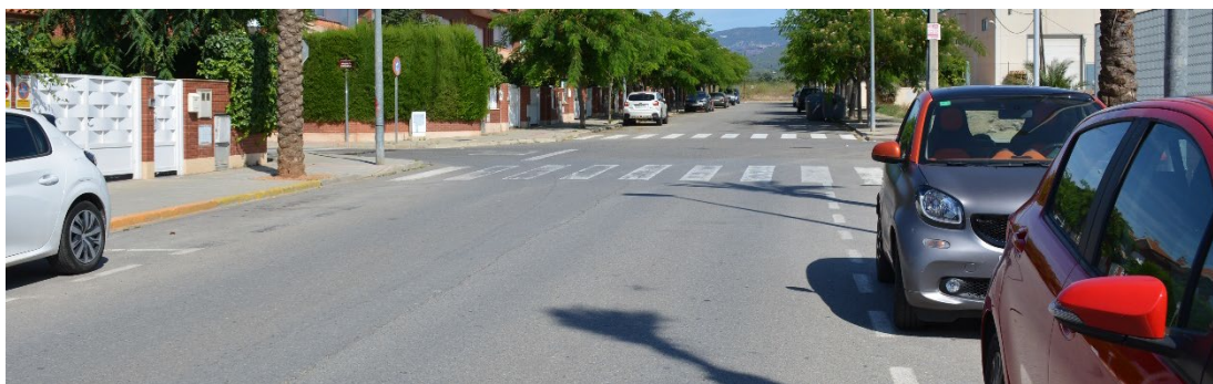
Imatge 64. Intersecció entre c. de Salvador Espriu i av. de Catalunya.
