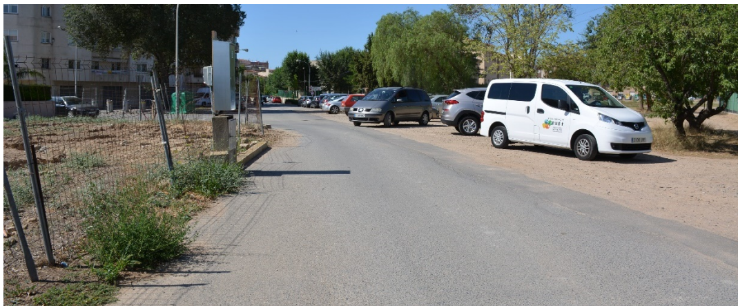
Imatge 68. Vista des de Camí de les Passeres. Manca de senyalització horitzontal i zona d'aparcament no regulat.
