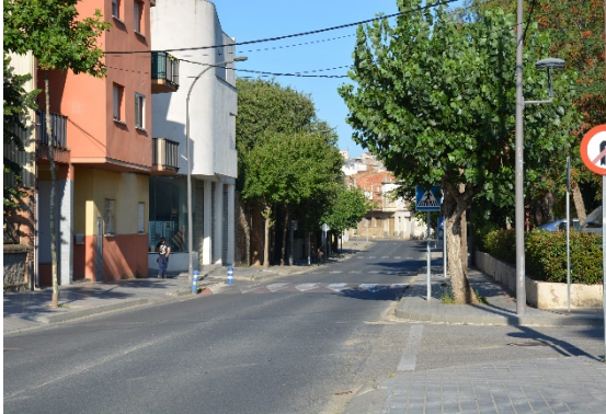
Imatge 2. Senyalització vertical amb manca de visibilitat per arbrat. Av. de Reus.
