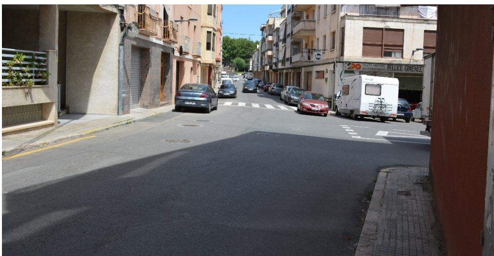
Imatge 40. Vista de Carrer de Sant Antoni, amb el creuament amb Carrer de Sant Pau.
