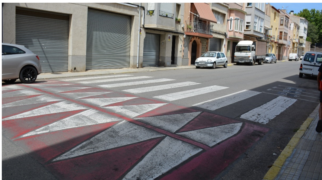
Imatge 21. Carrer de Sant Antoni. Doble sentit de circulació sense senyalització horitzontal per definir l'espai dels vehicles. S'ha disposat una esquena d'ase de formigó.
