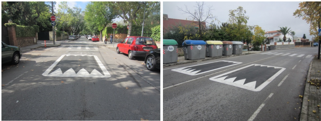
Imatge 84. Exemples de coixins berlinesos d'asfalt.
